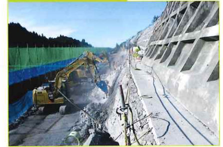
土工工事 拡幅箇所
