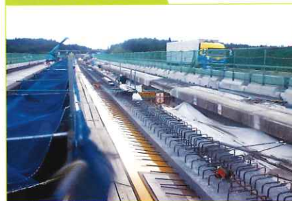
橋梁工事 拡幅箇所
