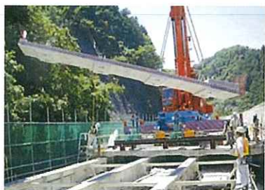
リニューアル工事(床版取替工事)状況
